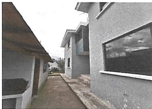
FACHADA LATERAL CAMINERIA
